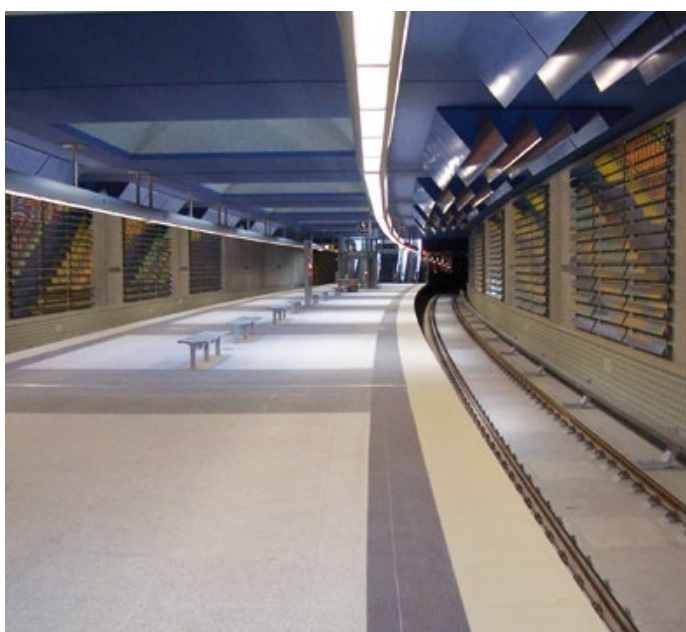
Aéroport Hamburg, Allemagne, sous-sol
