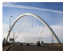
Ramstore Brücke (KZ)
