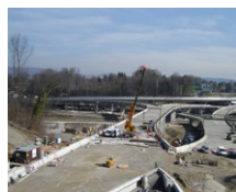
Pont Sihl (CH)
