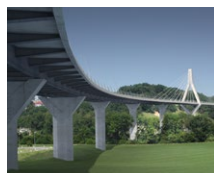
Pont de la Poya (CH)
