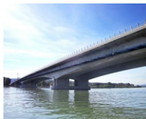
Traismauer Brücke (AT)
