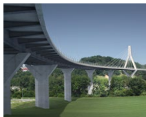
Pont de la Poya (CH)
