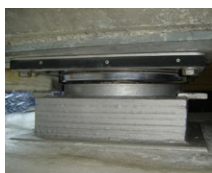
Kalottenlager
