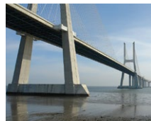
Vasco da Gama Brücke (PT)
