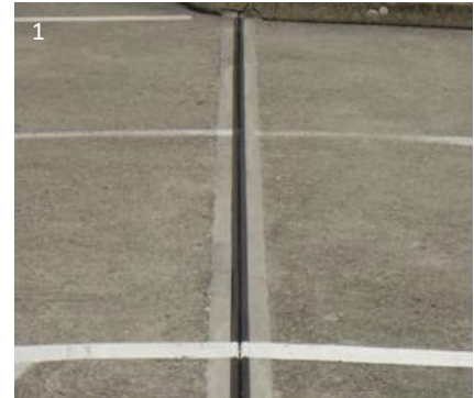
1 Einsatz in Parkdecke
