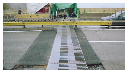
Ein TENSA®FINGER Gleitfingefuge (Typ GF600) im eingebauten Zustand
