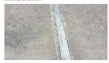
Die ROBO®SLIDE Gleitfläche wurde in die historischen Brückenlager eingelassen
