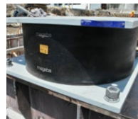
Blei-Elastomer-Lager
