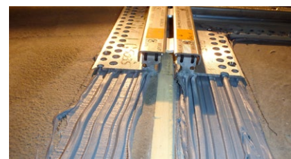
Verklebung der Profile auf dem Beton
