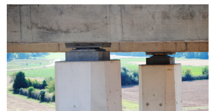
Kalottenlager an der Wehretalbrücke
