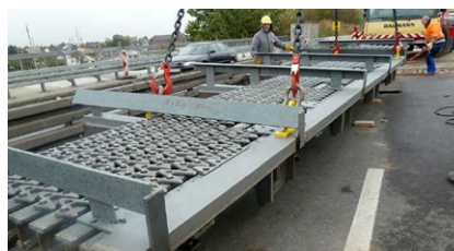
Neue Lamellendehnfuge Typ LR7-LS100 Einbauort Achse 14 – Stahlschluss
