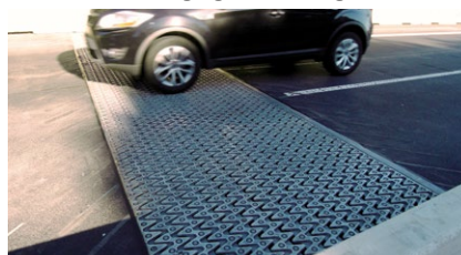
Neue Lamellendeckung Typ WSG 14-Plus. Die Länge einer Fahrbahnübergangshälfte beträgt ca. 13,90 m
