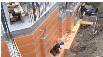
Montage der seitlichen Schwingungsdämmplatten
