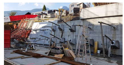
Fertig betonierte Ankerwand gleitend auf Liniengleitlager LASTO®STRIP XM
