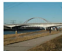
Dintelhaven Bridge (NL)
