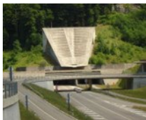
Tunnel Mont Terri St., (FR)
