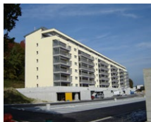
Bâtiment locatif, Givisiez
