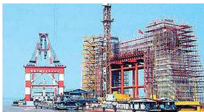
Construction du pilier de pont
