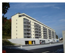
Bâtiment locatif, Givisiez
