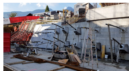
Mur d'ancrage en béton fini sur des appuis glissants LASTO®STRIP XM
