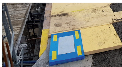
Montage des appuis glissants LASTO®FLONPAD GA-C sur la couronne murale
