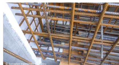
LASTO®FLONBLOCK sous la cage des fer d'armature, plus tard paroi glissant
