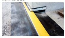
Joint préfabriqué avec plaque de recouvrement antidérapante
