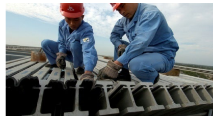
Eine TENSA®MODULAR Dehnfuge vom Typ LR24 bereit für den Einbau
