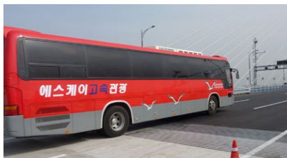
mageba Lamellenfuge in Betrieb
