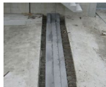
Fuge vor Betonage
