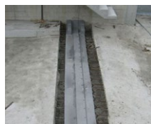
Fuge vor Betonage
