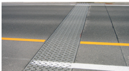
Eine TENSA®MODULAR Dehnfuge ausgestattet mit lärmreduzierenden Sinusplatten
