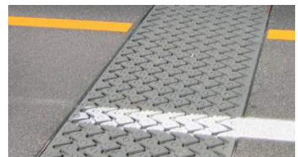
Eingebaute Lamellenfuge mit Sinusplatten
