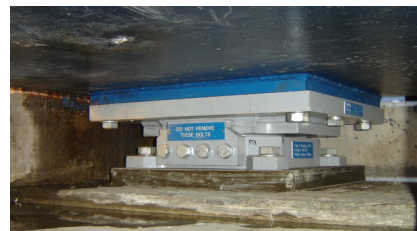
Eines der 633 erfolgreich eingebauten neuen Lager
