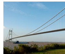
Run Yang Brücke (CN)
