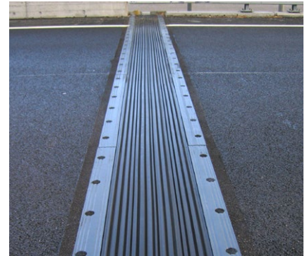
Eingebaute TENSA®MAT RM Dehnfuge
