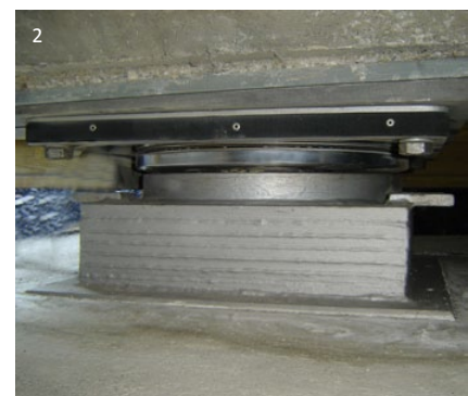
1 Einbaufertiges KE Lager mit Staubschutz und Bewegungsanzeige
