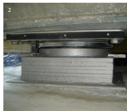
1 Einbaufertiges KE Lager mit Staubschutz und Bewegungsanzeige 2 Eingebautes KA Lager mit abgenommenem Staubschutz
