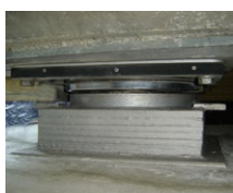
Kalottenlager
