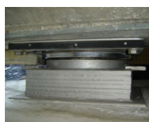
Kalottenlager
