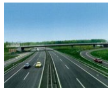
Autobahnüberführung Moosgasse, (CH)
