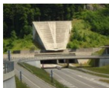
Tunnel Mont Terri St., (FR)
