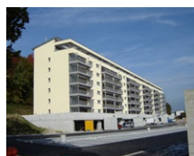
Bâtiment locatif, Givisiez
