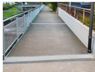
Fussgängersteg Heimbach, Schweiz
