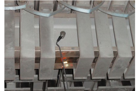
Vibrationsmessungen an einer Dehnfuge
