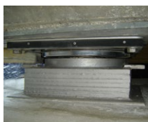
Kalottenlager
