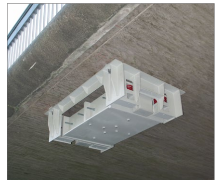
Präzise Schwingungsdämpfung mit einer Eigenfrequenz von 4,3 Hz und einer Schwingmasse von 3,5 t für eine Verkehrsbrücke in Kiel
