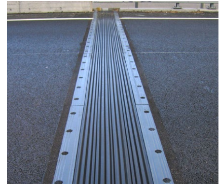
Eingebaute Tensa®MAT RM Dehnfuge
