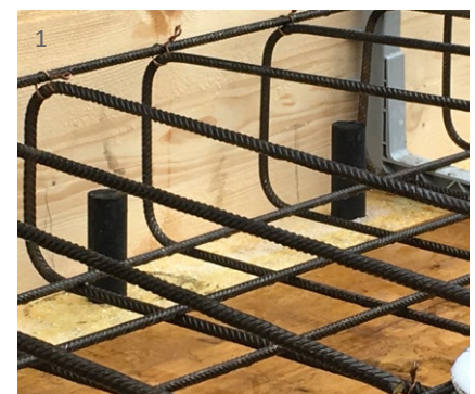
1 VIBRAX-STAIRTOP SL eingebaut als Wandsicherungselement
