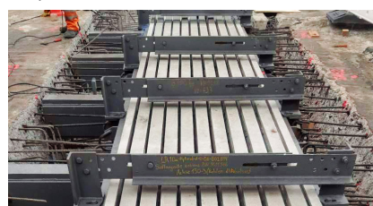
Montage des Lamellenübergangs TENSA®MODULAR in Hybridbauweise
