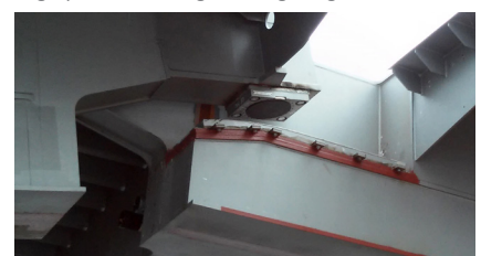
Lagerpunkte der Fingerverriegelung
