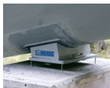
Kraftwerk Hugschwendi (CH)
