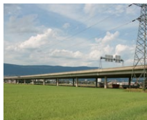
Viadukt Yverdon (CH)
