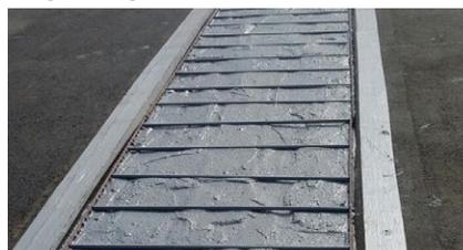
Neue Belagsdehnfuge POLYFLEX®ADVANCED PU im Kappenbereich, Einbau im Juli 2015
